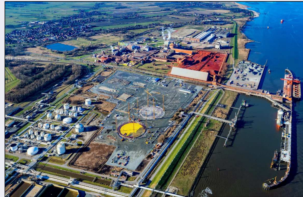
LNG Terminal Stade im Ausbau
